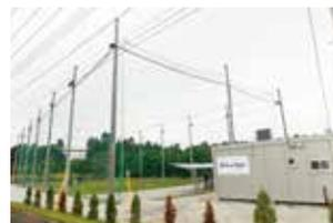
千葉県東金市にあるエンルートの専門スクール「E.R.T.S.」は、ネット付の飛行場を完備。奥行き120m×幅60m×高さ12mの飛行場内には模擬橋梁も備えています。
